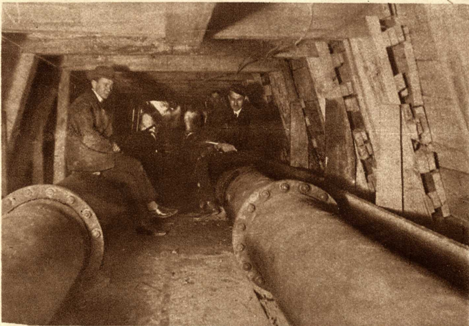
1) Odbudowany częściowo most im. księcia Poniatowskiego na Wiśle. 2) Budowa tunelu w Aleji 3-go maja. 3) Fragment odbudowanego mostu. 4) Wylot kanału burzowego. 5) Budowa wjaduktu nowego mostu kolejowego. 6) Przewody wodociągowe łączące wschodnią część miasta z zachodnią, obnażone obecnie przy budowie tunelu. 7) Obecny stan robót w śródmieściu.
