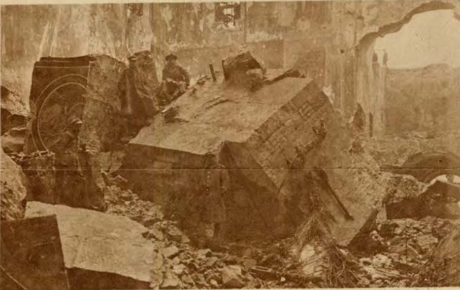
Dla przyspieszenia rozbiórki soboru na Placu Saskim, postanowiono przy pomocy materiałów wybuchowych zwalić 4 kolumny granitowe i tym sposobem podważyć sklepienie. Zdjęcie nasze przedstawia granitowe brzozy soboru, zwalone wybuchem, leżące na wysokość paru pięter na posadzce soboru.
