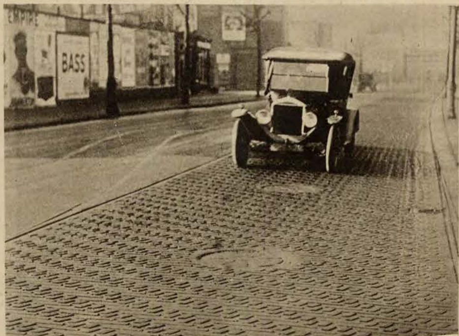
Ciekawą drogę zbudowano w Acton (Anglja) dla samochodów w celach eksperymentalnych. Droga wyłożona jest drewnianą kostką, która przykryta jest gumowymi paskami. Dotychczasowe wyniki są zupełnie zadowalające.
