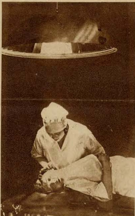
Lampa, która nie rzuca cienia. Przez odpowiednie rozmieszczenie soczewek uzyskuje się załamanie światła, które za pomocą lusterek umieszczonych wewnątrz umbr, koncentruje się na danym przedmiocie. Na zdjęciu widoczny brak cienia. Lampa ma nieocenioną wartość przy zabiegach chirurgicznych.
