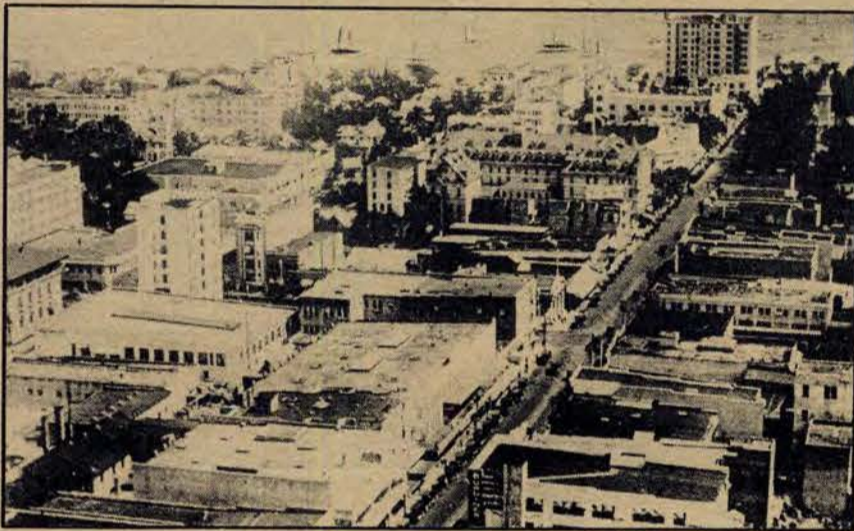
Piękne nowoczesne miasto Miami, które obecnie po przejściu szalonego orkanu, przedstawia kupę gruzu.
