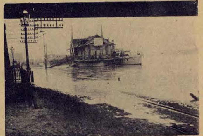
Przybór wody w Wiśle zalał nadbrzeżny tor kolejowy w Warszawie.
