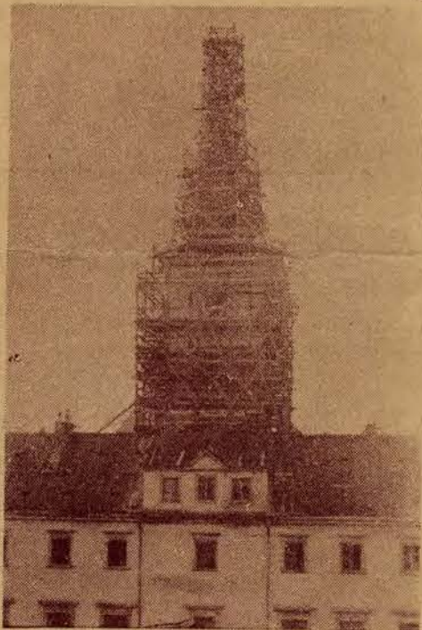
Remont wieży zegarowej.
