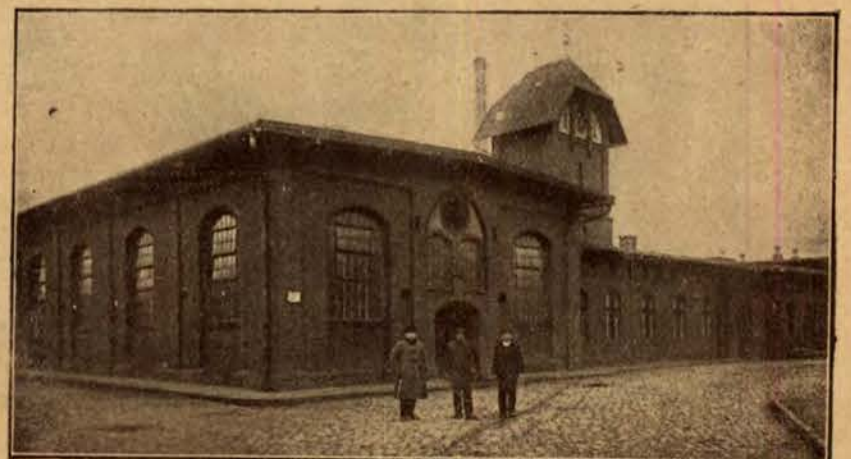
Budynek rzeźni miejskiej w Ostrowie Wlkp.
