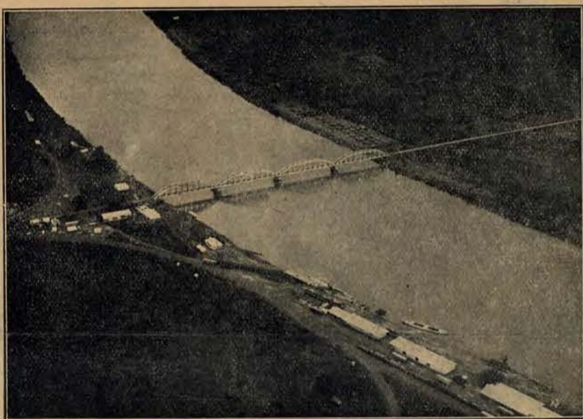
Bukama. Most kolejowy linii B. C. K.
