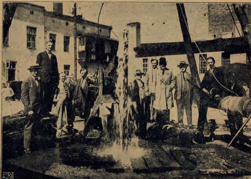
Przy biciu studni artezyjskiej w Szpitalu Miejskim w Kaliszu natrafiono na niezwykle obfite źródło, które wytrysnęło na 4½ mtr. w górę. Źródło to jest tem ciekawsze, że posiada ciepłość 18 st. Cel. Przy studni stoją: x prezydent m. kalisza Szarros, xx Ławnik Kubasiak, xxx przedsiębiorca budowy studni Hołman.
