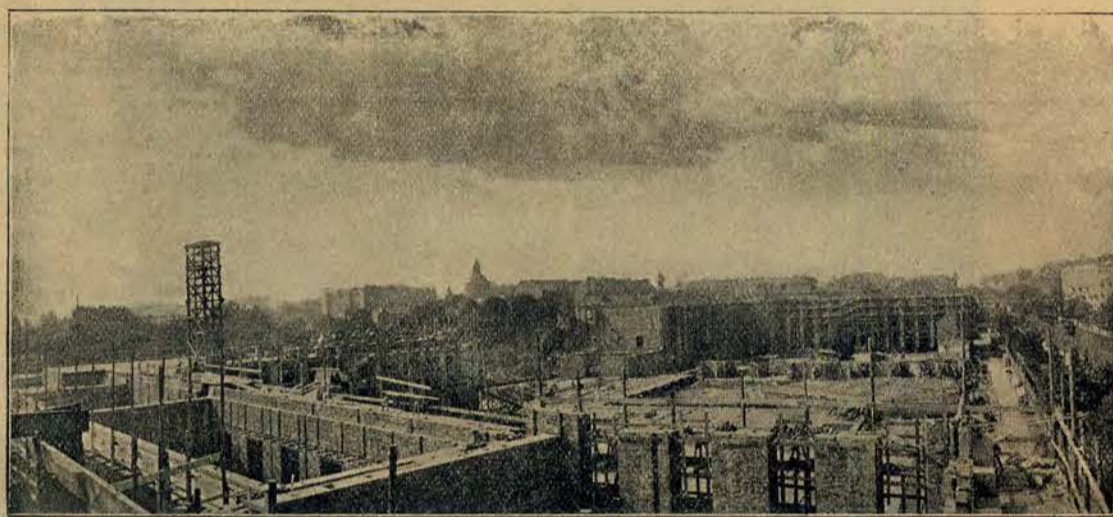
Budowa Muzeum Narodowego w Warszawie. Stan robót w końcu września.
