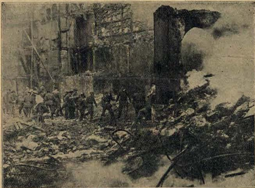
Gaszenie płonącego teatru.
