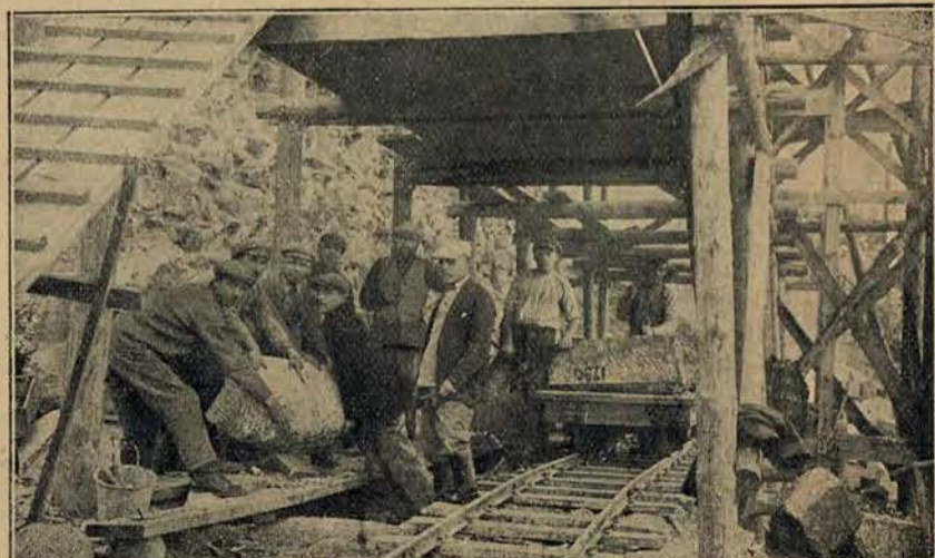
Układanie pierwszej warstwy przyczółka nadbrzeżnego.
