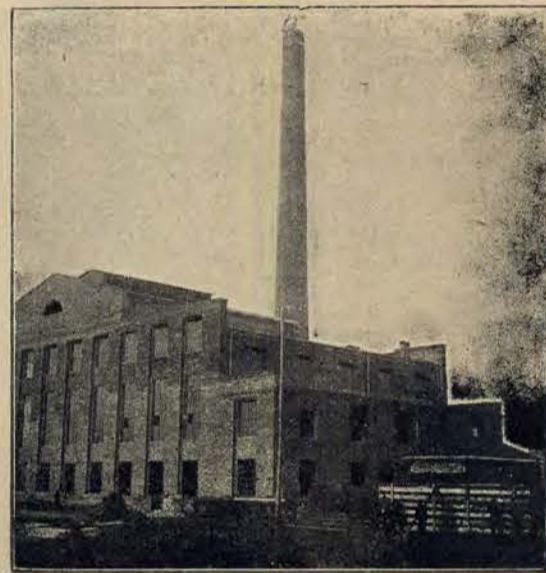
Nowa miejska elektrownia w Płocku.
