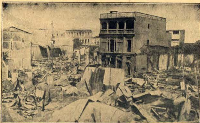
Widok ogólny miasta Talca, w którym zginęło pod gruzami domów 150 osób
