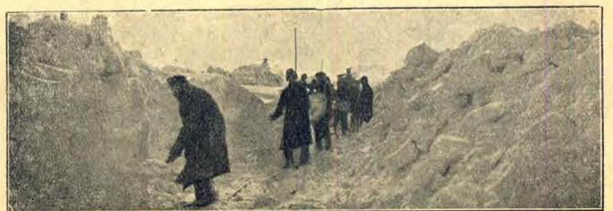
200 robotników odkopuje tor kolejowy kolejki kalisko-tureckiej
