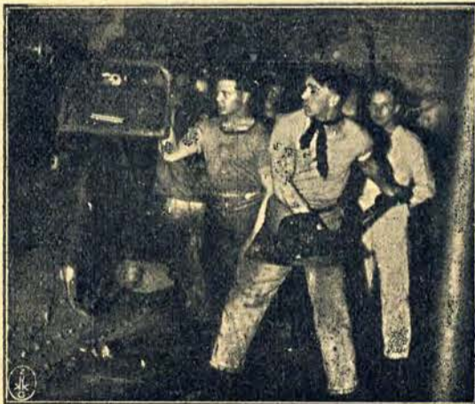
Najcięższą jest praca w kotłowni, w której temperatura bynajmniej nie jest „rajska”.
