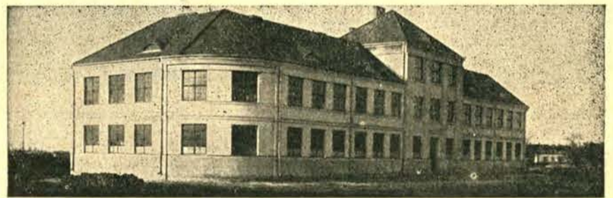
Nowowbudowana 7-mio klasowa szkoła powszechna w Osiecinach, pow. Nieszawskiego.
