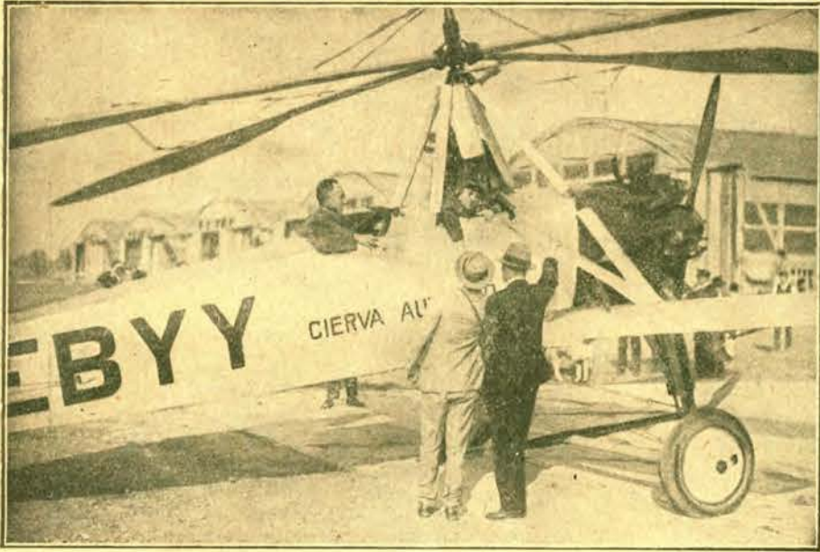
„Auto - giro” aeroplan konstrukcji Hiszpana de La Cievra, zaopatrzony w skrzydła na osi pionowej.
