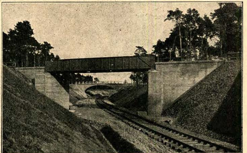
Szlakiem węgla polskiego. Wiadukty (kolejowy i szosowy) pod Bydgoszczą.
