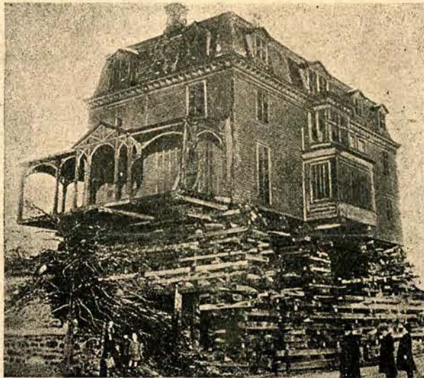
Charakterystyczny obrazek z ruchu budowlanego w Niemczech: gdy „nadbudowanie” się nie udaje, stosują Niemcy „podbudowanie”.
