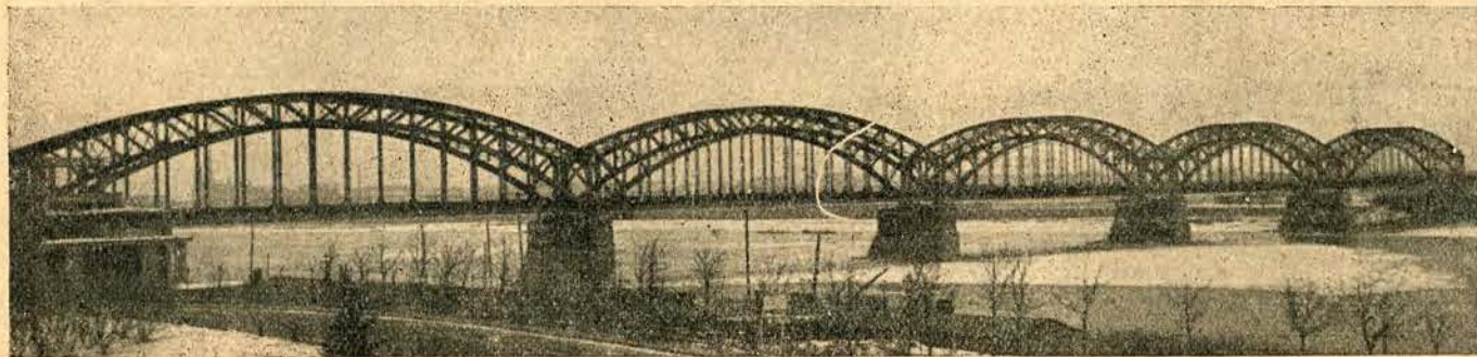
Budowa mostu kolejowego na Wiśle w Warszawie została ostatecznie ukończona.
