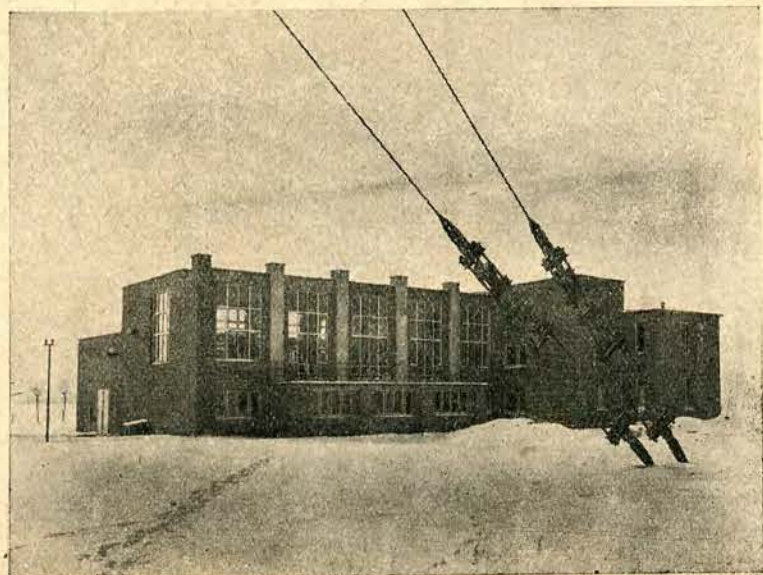
Właściwy budynek stacji nadawczej, widziany z boku. Na przednim planie zaopiecznienie masztów antenowych.
