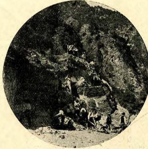
Budowa tunelu w górach alpejskich.
