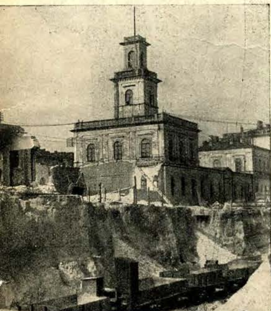
awie. Tunel, prowadzony od Wisły, z drugiej łączył się przy Dworcu Głównym, którego budowę rozpoczęto rozbierać.
