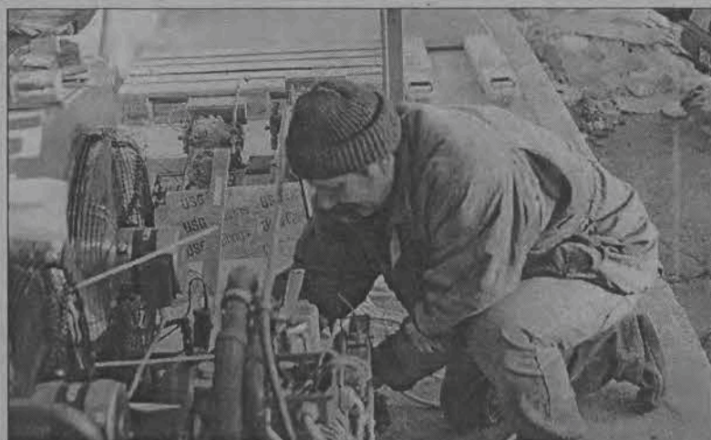
Większość prac przy urządzaniu „Lewiatana” odbywa się wewnątrz, ale niekiedy trzeba pracować na dworze, jak np. teraz, przy montażu urządzeń chłodniczych
