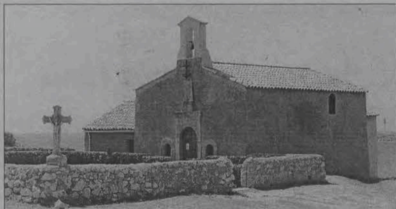
Nawet proste budowle sakralne mają tam w sobie wiele niepowtarzalnego uroku. Na zdjęciu: zawieszona nad nadmorskim urwiskiem kapliczka w St. Croix opodal Marsylii.
