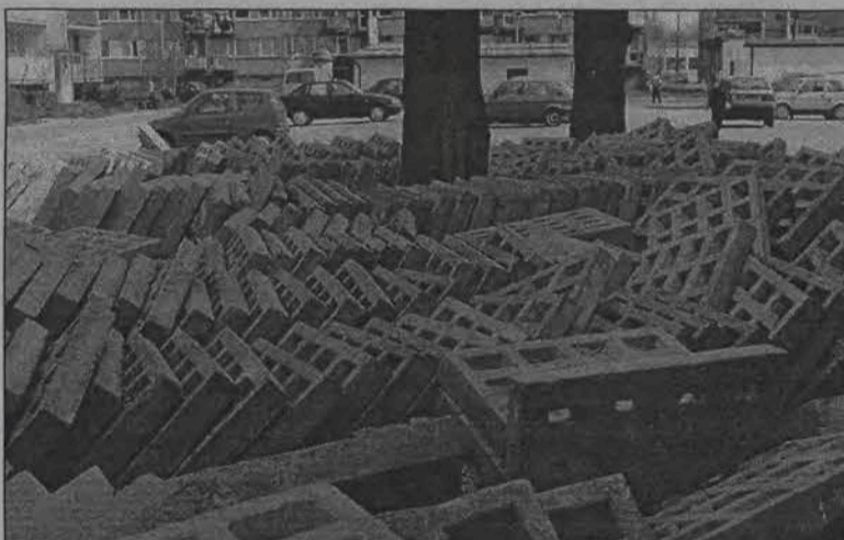
Utwardzony parking na kilkadziesiąt samochodów powstaje w rejonie bloków numer 9 i 12 na osiedlu Bratkowice w Łowiczu. Na wyrównanym terenie zostanie ułożonych ponad 400 płyt typu yomb. Zostały one przekazane przez samorząd miejski po uprzednim wykorzystaniu ich na placu mszy świętej papieża Jana Pawła II 14 czerwca ubiegłego roku. Prace przy układaniu płyt finansuje ŁSM.
