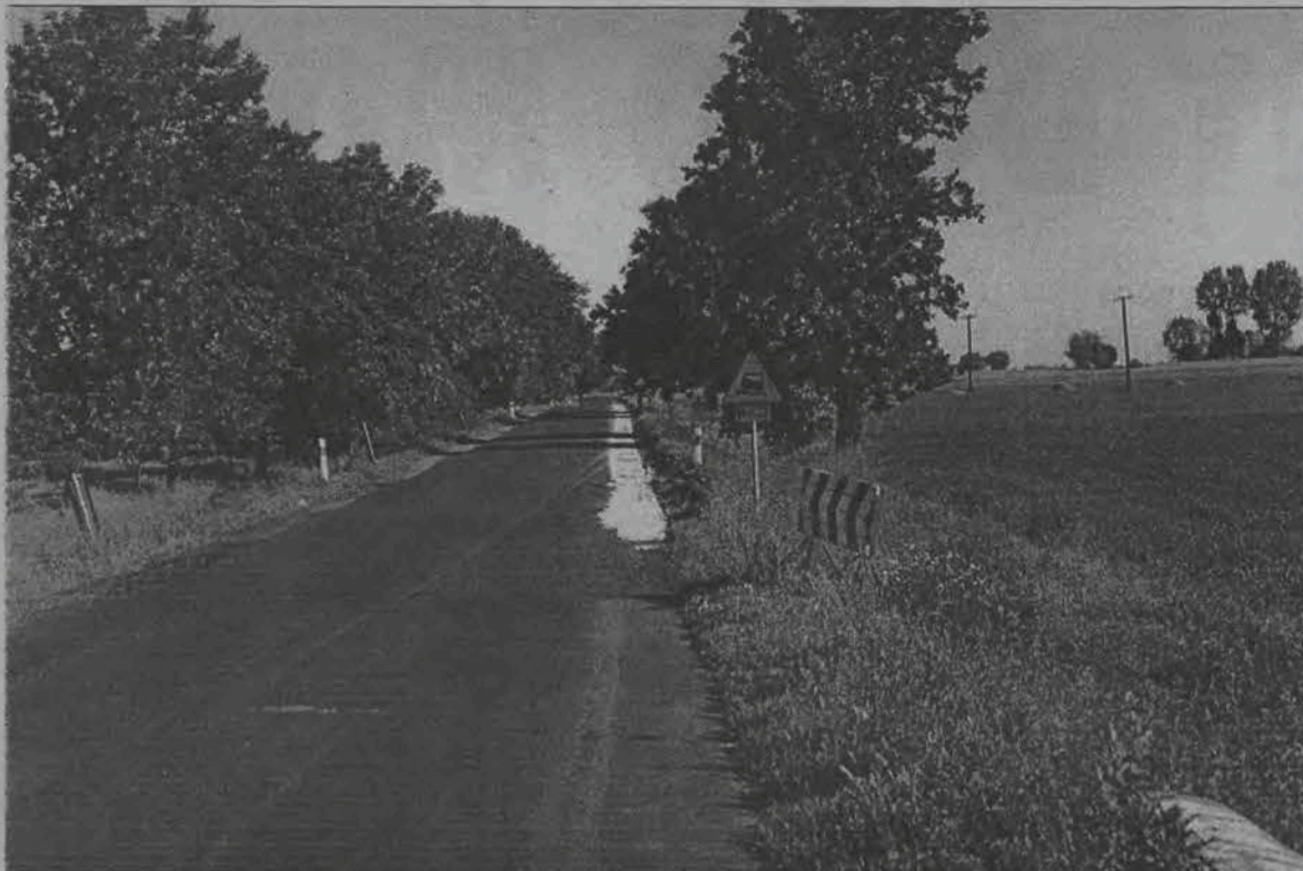
Droga do Kiernozi będzie szersza. Na 4-kilometrowym odcinku drogi wojewódzkiej z Łowicza do Kiernozi prowadzone są prace przy utwardzaniu poboczy. Dotychczas krawędzie tego odcinka drogi - leżącego dawniej w woj. płockim - były bardzo nierówne, a droga węższa niż do wysokości wsi Karsznice - dokąd sięgało woj. skierniewickie. Widoczna na zdjęciu różnica nawierzchni, była granicą województw. Prace prowadzone będą do 20 czerwca, pobocza zostały już utwardzone, zostanie na nie położona masa bitumiczna. Wraz z nowymi poboczami droga będzie miała 6 m szerokości twardej nawierzchni.
