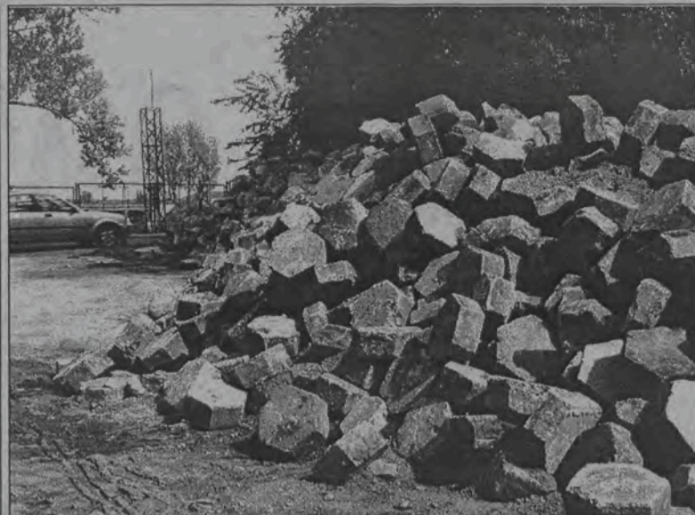
Rozpoczęły się prace związane z budową nowego budynku Zakładu Energetycznego na ulicy Mostowej. Nowy gmach stanie tuż obok starej siedziby zakładu. Teren budowy ogrodzono parkanem i zdjęto trylinkę odsłaniając teren budowy. Złożono ją na leżącym naprzeciwko parkingu. W nowym budynku na piętrze znajdować się będzie m.in. biuro obsługi klienta, a na pierwszym piętrze m.in. biura księgowości i kierownictwa. Na drugim piętrze budowanego obiektu mieścić się będzie Rejonowa Dyspozycja Ruchu. O budowie szerzej napiszemy wkrótce. Na zdjęciu: usunięta z miejsca przyszłej budowy trylinka.
