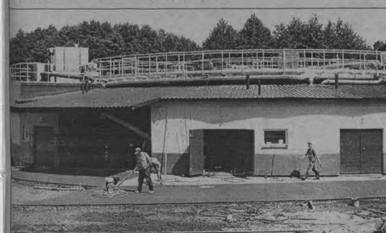
Oczyszczalnia ścieków w Łyszkowicach
