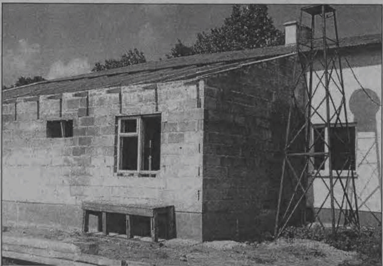
Po remoncie Dom Ludowy będzie mógł jeszcze lepiej służyć mieszkańcom Jamna.
