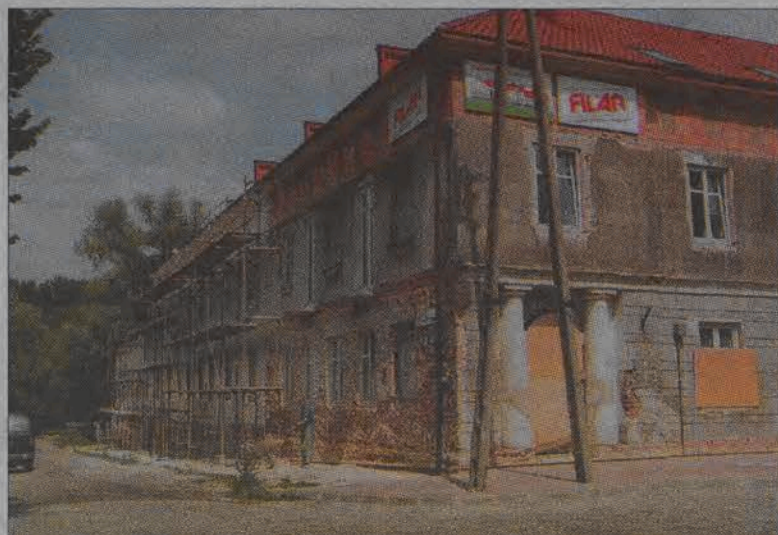
Ten widok warto zapamiętać, by - gdy na ścianach pojawi się nowy tynk - wiedzieć, że tak to wyglądało.
