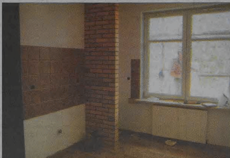
W niektórych pomieszczeniach za kilka tygodni zamieszkają już ludzie.
