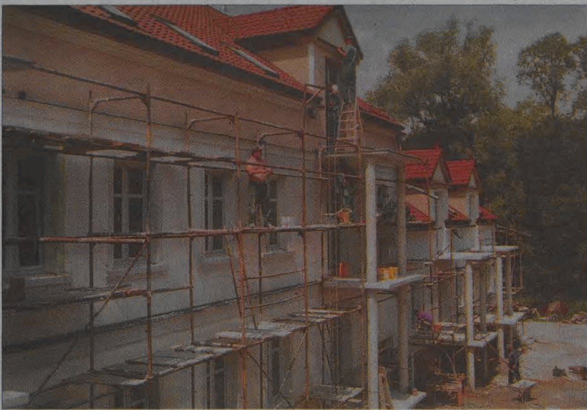
Podwórko będzie strzeżone, zamykane, a wewnętrzne fasady wzbogacone o elementy, których pierwotnie nie było. Tuż za płotem - morze zieleni: park na Błoniach na wyciągnięcie ręki.
