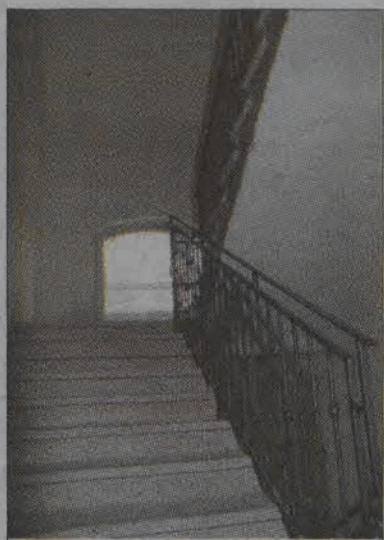
Klatki schodowe powstały przestronne i starannie wykończone.
