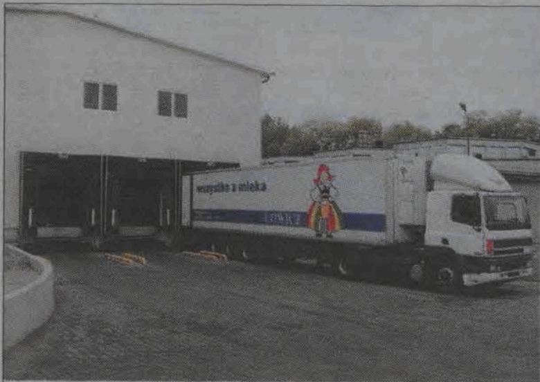
Rampa do załadunku od zewnątrz...
