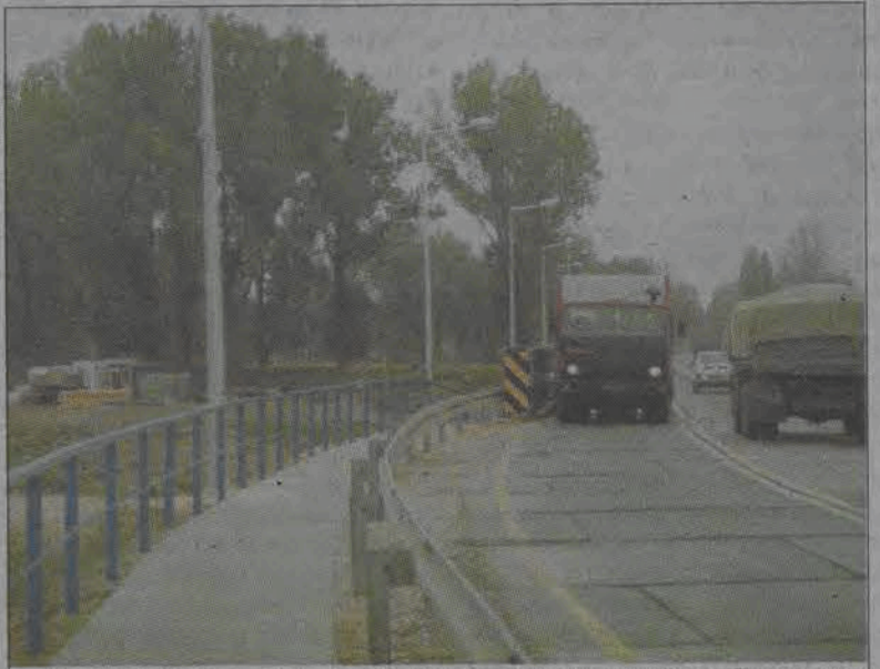
Na moście tymczasowym, zastępującym remontowany most na Bzurze przy ruinach zamku prymasowskiego w Łowiczu, zostały w ubiegłym tygodniu zainstalowane lampy. Po prostu było tam trochę za ciemno... - uzasadnia ten krok kierownik Zarządu Dróg Krajowych w Łowiczu Paweł Chojnacki. Dotychczasowe ciemności doskwierały nie tyle kierowcom, co pieszym, którzy kładką w nocy przechodzili przez most. (mak)
