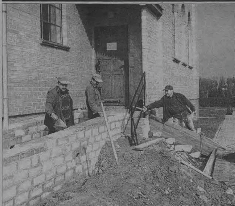
Dużym utatwieniem dla kilku osób niepełnosprawnych mieszkających na terenie parafii a także dla rodzin z małymi dziećmi w wózkach będzie wykonywany obecnie podjazd przy bocznym wejściu do kościoła Chrystusa Dobrego Pasterza w Łowiczu od strony ulicy Jana Pawła II. Podjazd będzie bardzo łagodny, a więc całkowicie bezpieczny, zgodnie z przepisami spadek będzie wynosił 5%. (mwk)
