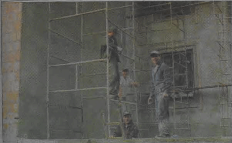
Pijarska prawie otynkowana. Dobiegają końca prace związane z tynkowaniem budynku szkół pijarskich. W minionym tygodniu zakończyły się prace przy ścianie od strony podwórka, aktualnie tynkowana jest ostatnia jego część, ta od strony ul. Pijarskiej. (aj)
