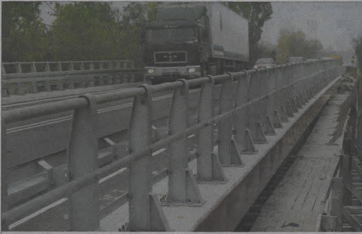
Ku końcowi zbliża się remont poręczy, belek podporeczowych i krawędzi wiaduktu w ul. Poznańskiej nad torowiskiem w stronę Kutna. Na wiadukcie nie obowiązują już ograniczenia w ruchu, otwarte są obydwie strony jezdni. Trwają ostatnie prace związane z zabezpieczeniem antykorozyjnym części metalowych. Potem zostanie rozebrana drewniana kładka, po której poruszali się robotnicy i zdemontowane podpory konstrukcji kładki oraz te, które podtrzymują świeżą wylewkę betonową. (mak)
