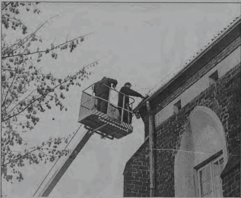
Przy pracach nie ustawiano rusztowań, posługiwano się podnośnikiem
