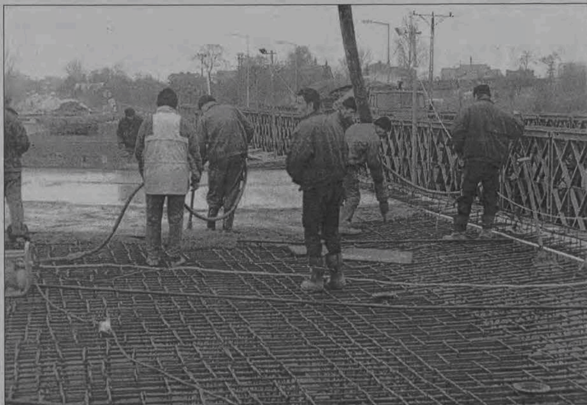
Jak betonowała się stal Ponad 750 ton będzie ważyła betonowa płyta nowego mostu, który jest budowany na Bzurze na trasie nr 14 w Łowiczu. W piątek, 24 listopada rozpoczęło się betonowanie płyty, w momencie zamykania tego numeru Nowego Łowiczana jeszcze trwało. Beton jest podawany z „gruchy”, potem od razu ubijany (zagęszczany) za pomocą specjalnej listwy wibrującej poruszającej się na odpowiednio wypoziomowanych, metalowych rurkach ułożonych z odpowiednim spadkiem. „- Najbardziej obawiamy się ulewnego deszczu. Gdyby zaczął porządnie padać, woda wyplukalaby beton” - powiedział nam nadzorujący pracę inżynier Paweł Nowak z Kielca.
