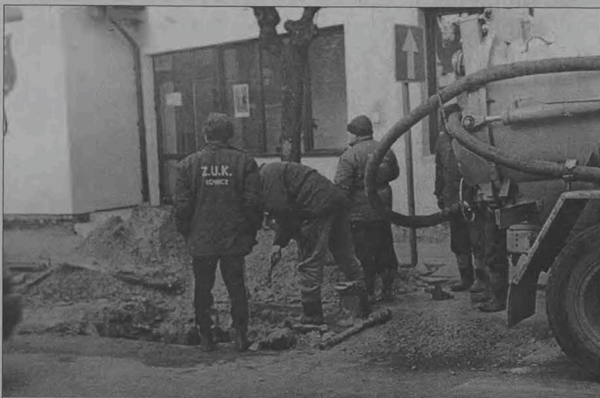
Kilka godzin pracy musieli poświęcić w ubiegły piątek pracownicy Oddziału Wodociągów i Kanalizacji łowickiego Zakładu Usług Komunalnych na wymianę uszkodzonej zasuwę na wodociągu znajdującym się pod Alejami Sienkiewicza. Uszkodzenie było drobne, ale skutki jego nieusunięcia, mogłyby być katastrofalne. Na jezdni tworzyłoby się lodowisko i o wypadek nie trudno... - powiedział nam kierownik łowickich wodociągów Zbigniew Bochenek.
