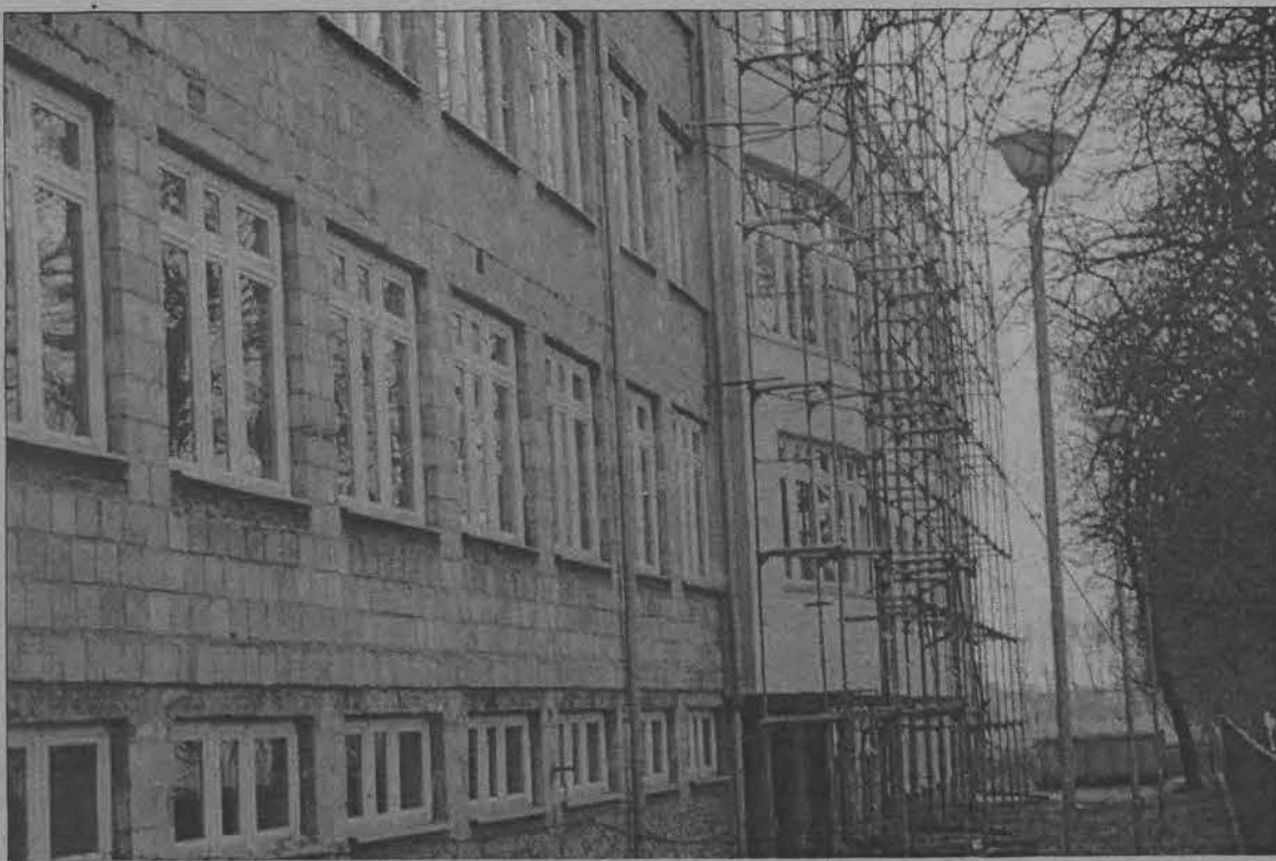
Wszelkie prace przy budynku ZSZ nr 4 przy ulicy Kaliskiej mają być ukończone do końca kwietnia.
