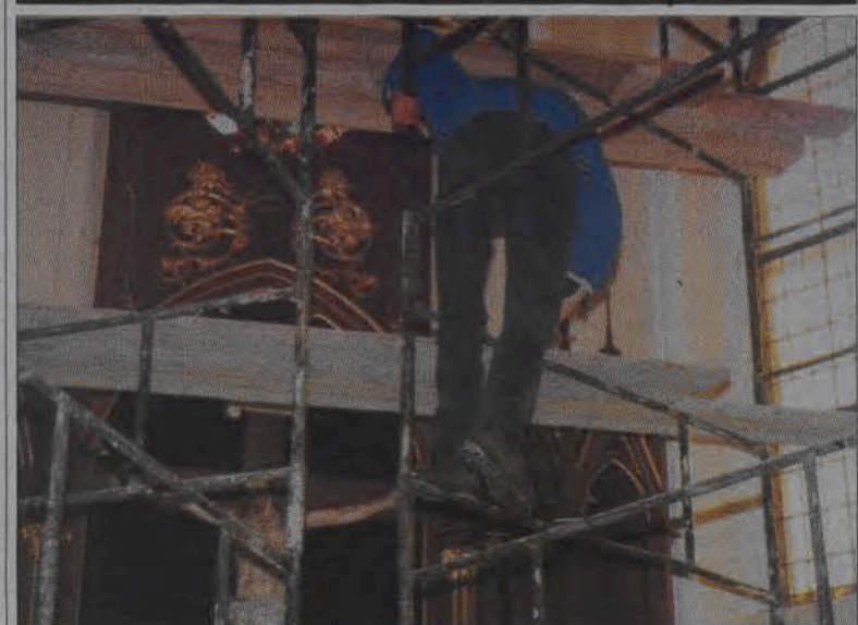
Do końca zbliżają się prace związane z malowaniem wnętrza kościoła św. Jakuba w Zdunach. Malowanie zakończone zostanie przed świętami, koszty prac pokrywane są z darów wiernych. (aw)
