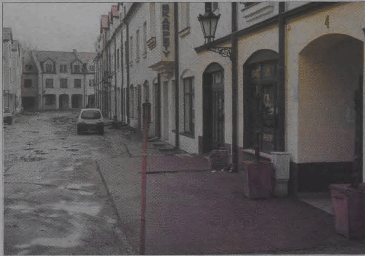
Ulica Krakowska. Tak też może wyglądać centrum handlowe. Po oddaniu do użytku nawierzchni będzie tu atrakcyjnie.
