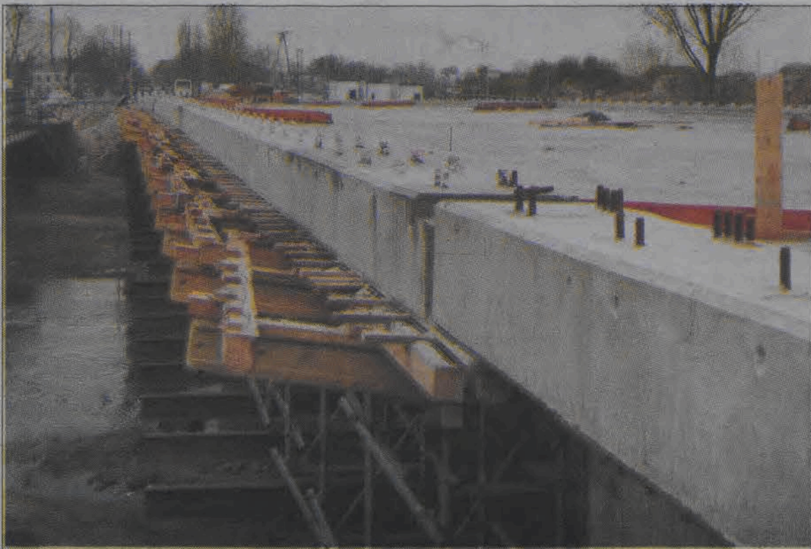
Do końca sierpnia. Od razu po świętach rozpoczęło się betonowanie przyczółków oraz krawędzi wznoszonego niemal od podstaw na nowo mostu na Bzurze w Łowiczu, na obwodnicy łódzkiej. Prace na moście zostały wcześniej przerwane na okres zimowy ze względu na niskie temperatury. Remont mostu jest prowadzony od czerwca ubiegłego roku i pierwotnie miał zakończyć się pod koniec października ubiegłego roku. Po rozebraniu płyty mostu jednak okazało się, że wymiany wymagają również stare dźwigary mostu, więc remont ma potrwać nawet do końca sierpnia. (mak)
