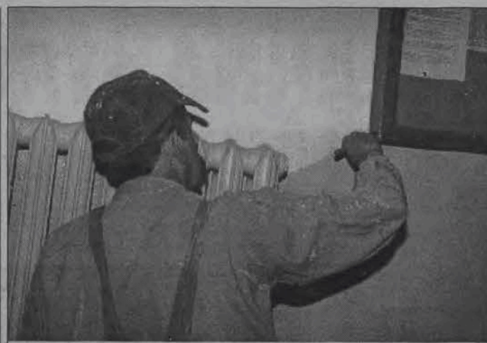
Mieszkańcy bloku na osiedlu Starzyńskiego 3 zadowoleni są z prac remontowych, jakie na zlecenie ŁSM przeprowadziła w ich klatkach grupa remontowa Krzysztofa Bazaka. Prace wykonywane są dokładnie, jakość robót jest bardzo dobra, co zauważył również artysta malarz Andrzej Biernacki. Ważne, że pracownicy nie zostawiają po sobie brudu - zauważyła jedna z lokatorek. (aw)
