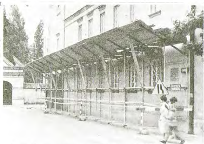
Rozpoczęła się częściowa wymiana dachu na budynku Muzeum Narodowego w Łowiczu. Prace, finansowane przez Muzeum, wykonuje łowicka firma budowlana FHAR.
