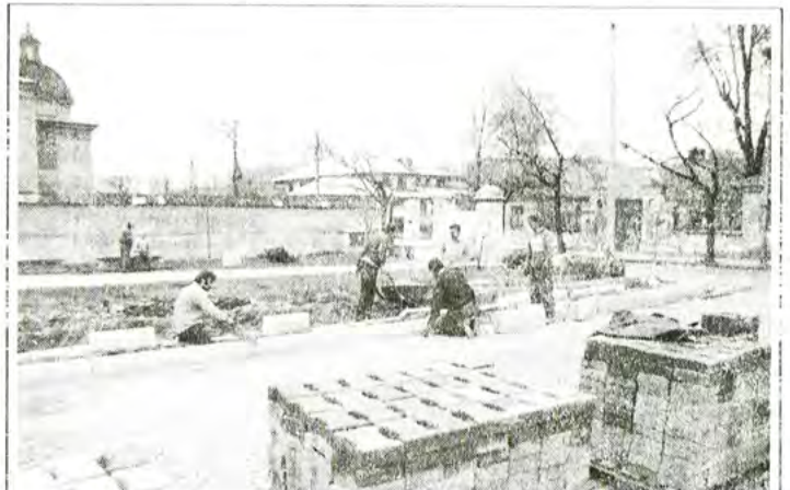
Przez cały poprzedni tydzień trwały prace przy porządkowaniu terenu wokół miejsca, na którym stanie pomnik Władysława Grabskiego. Niejeden z przechodzących musiał sobie zadać pytanie czy czerwona kostka brukowa jest w tym miejscu najlepszą nawierzchnią z możliwych.
