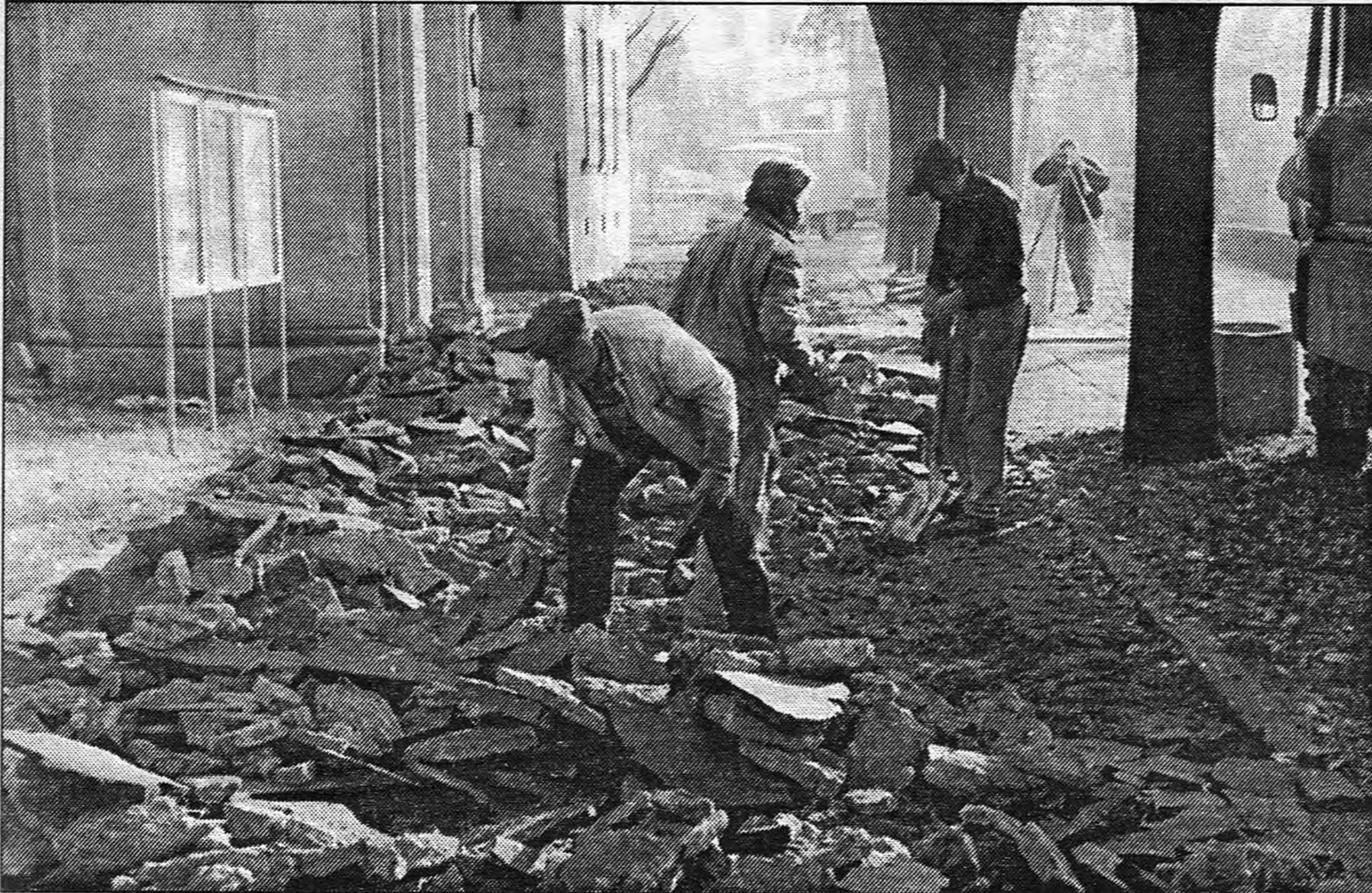
Trwają prace przygotowawcze do układania brukowej kostki chodnikowej na chodniku wokół muzeum po północnej stronie ulicy 3 Maja i od strony Rynku Kościuszki. Zdjęto już całkowicie, dotychczasową nawierzchnię chodnika.
