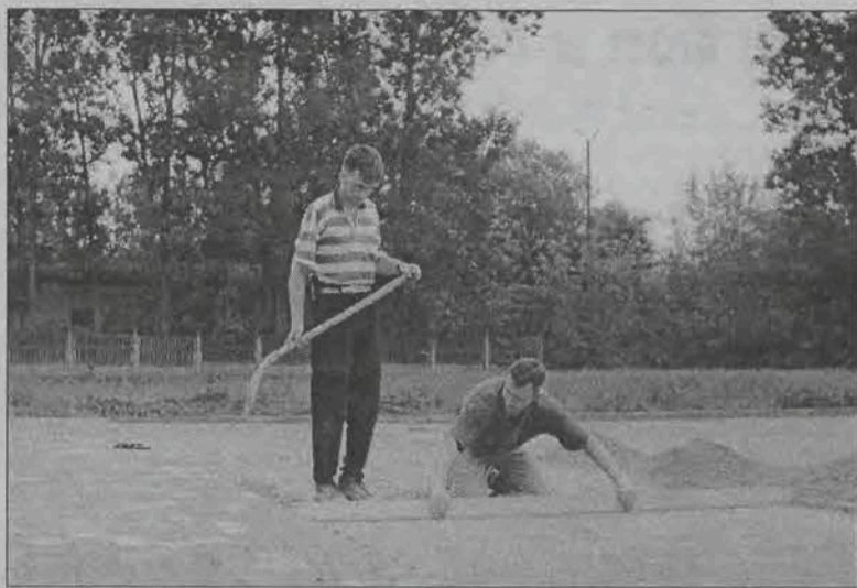
Pracownicy firmy „Jarmax” przy układaniu kostki.
