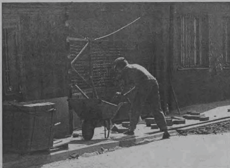
Nowy chodnik na Sokołowskiej. Stare płyty chodnikowe przy ulicy Sokołowskiej w Bolimowie od kilkunastu dni wymieniane są na kostkę brukową. Prace wykonywane są na zlecenie Zarządu Dróg Krajowych w Skierniewicach. (ljs)
