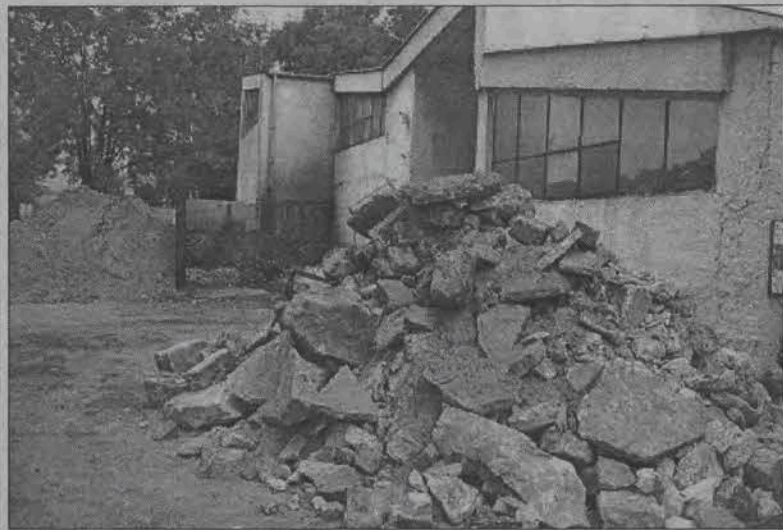
Prace inwestycyjne przy kotłowniach jeszcze trwają.
