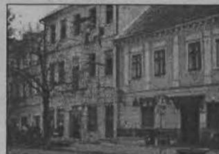
Na razie wymiana stolarki okiennej i nowa elewacja, a w przyszłości wymiana stropów.
