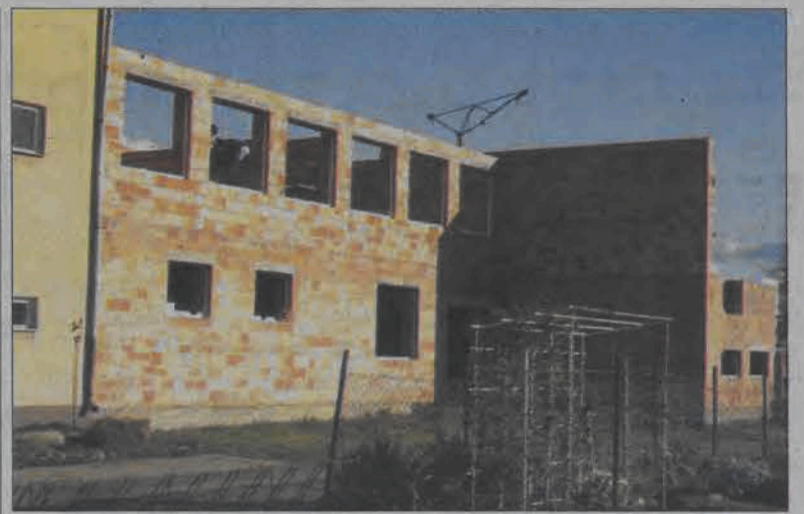
Mimo kłopotów finansowych mury sali gimnastycznej ciągle rosną.
