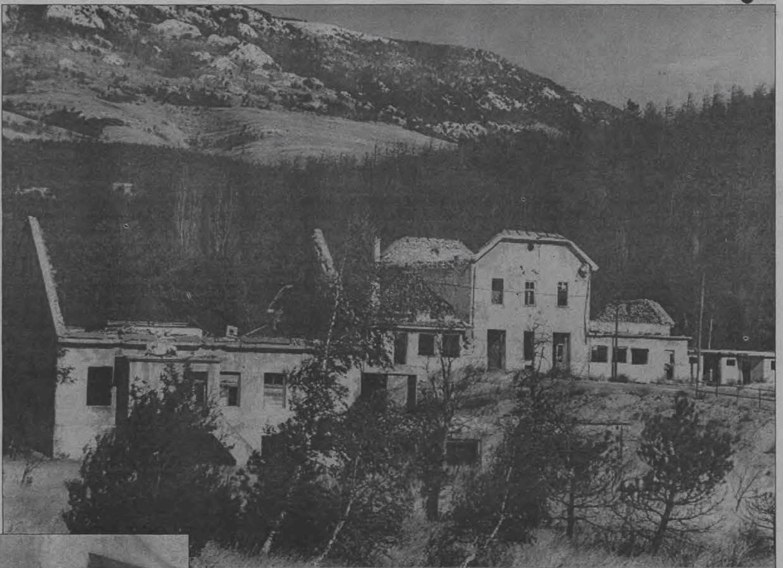
Zniszczone są nie tylko domy prywatne, ale i szkoły, szpitale, dworce kolejowe. Podobnie jest za tą górą - w Bośni.
