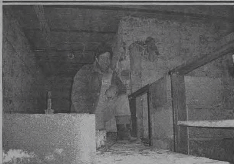
Posuwają się prace remontowe w budynku Łowickiego Ośrodka Kultury przy ul. Podrzecznej. Zakończono wymianę konstrukcji i pokrycia dachu. Aktualnie trwa osuszanie ścian, wykonywanie instalacji wodno-kanalizacyjnej, c.o. i elektrycznej. (aj)
