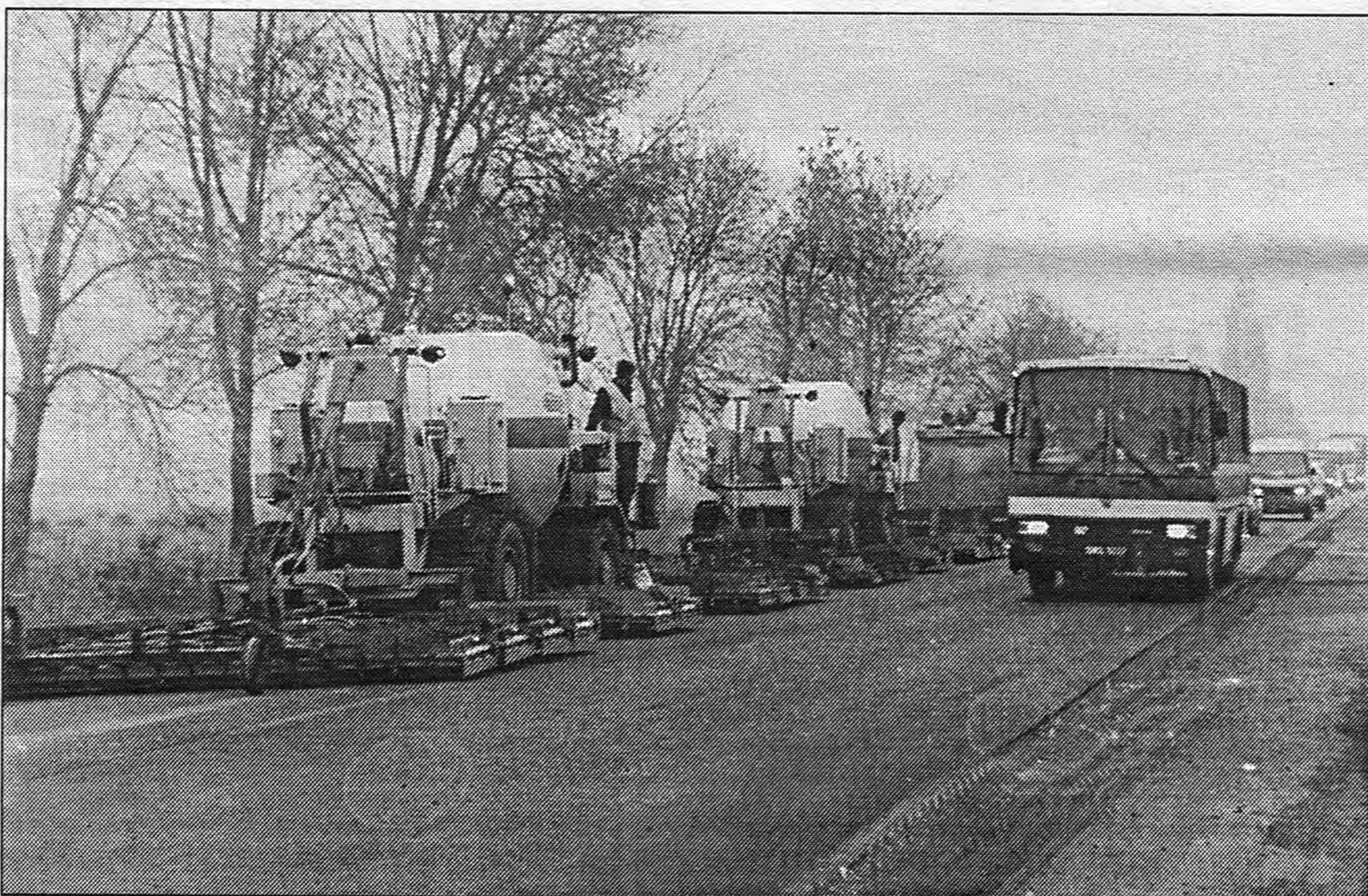
W ciągu minionych dni, nie wyłączając nawet święta Niepodległości 11 Listopada, ekipa firmy drogowej DROMEX kładła nową nawierzchnię na przechodzącym przez Łowicz odcinku trasy nr 2 Poznań – Warszawa. Stosowano metodę tzw. „remixingu”, polegającą na podgrzewaniu zestawami olbrzymich, płaskich palników powierzchniowej warstwy starej nawierzchni, uzupełnianiu jej masą bitumiczną i utwardzaniu. Ciąg maszyn remiksujących wraz z jadącymi z tyłu walcami zajmował ponad sześćdziesięciometrowy odcinek drogi. Ruch odbywał się po jednym pasie, stąd DROMEX zainstalował przenośną sygnalizację świetlną regulującą przepływem samochodów, raz z jednej raz z drugiej strony. Tworzące się korki sięgały kilkuset metrów długości.
