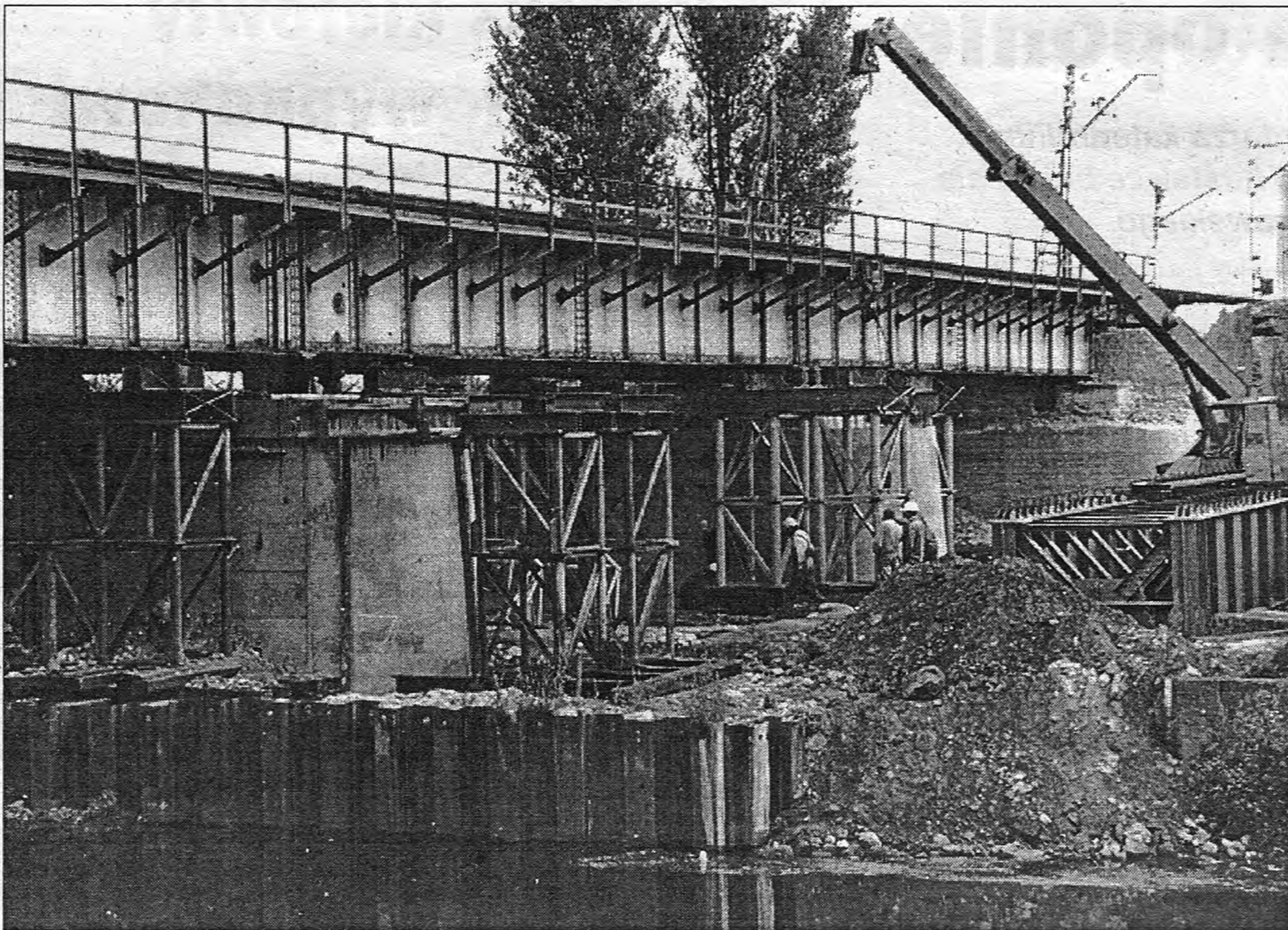
Remont filarów już wkrótce
