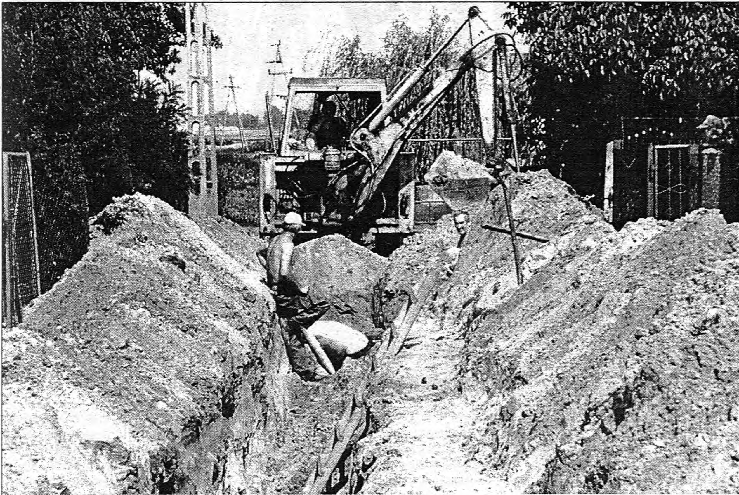
Prace w ulicy Wiosennej
