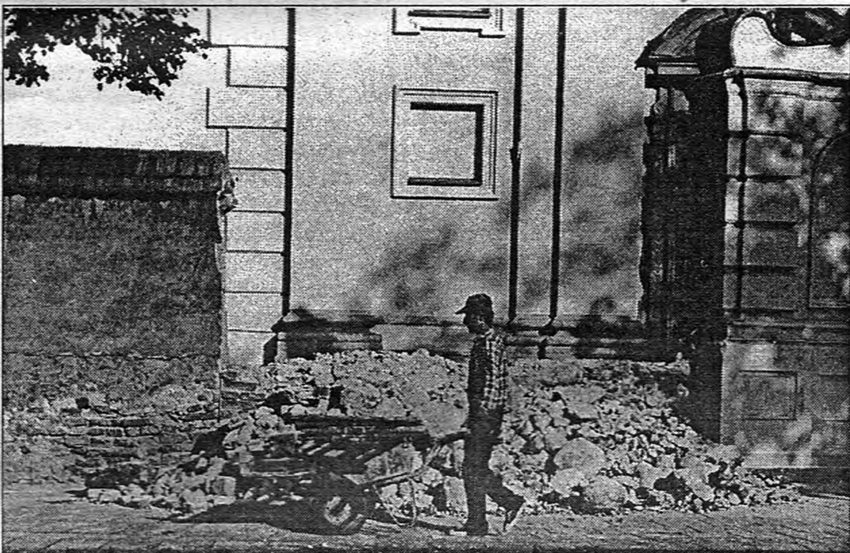
POCZĄTEK KOŃCA KATEDRALNEGO MURU. O tym, że po wielu dyskusjach decyzja rozbioru muru wokół katedry zapadła, pisaliśmy wiosną. Teraz w końcu przystąpiono do prac rozbiorczych, zaczynając od najmniej uczęszczanej strony Starego Rynku, przy wylocie ulicy Podrzecznej. To historyczne zdjęcie wykonaliśmy we wtorek 3 września.
